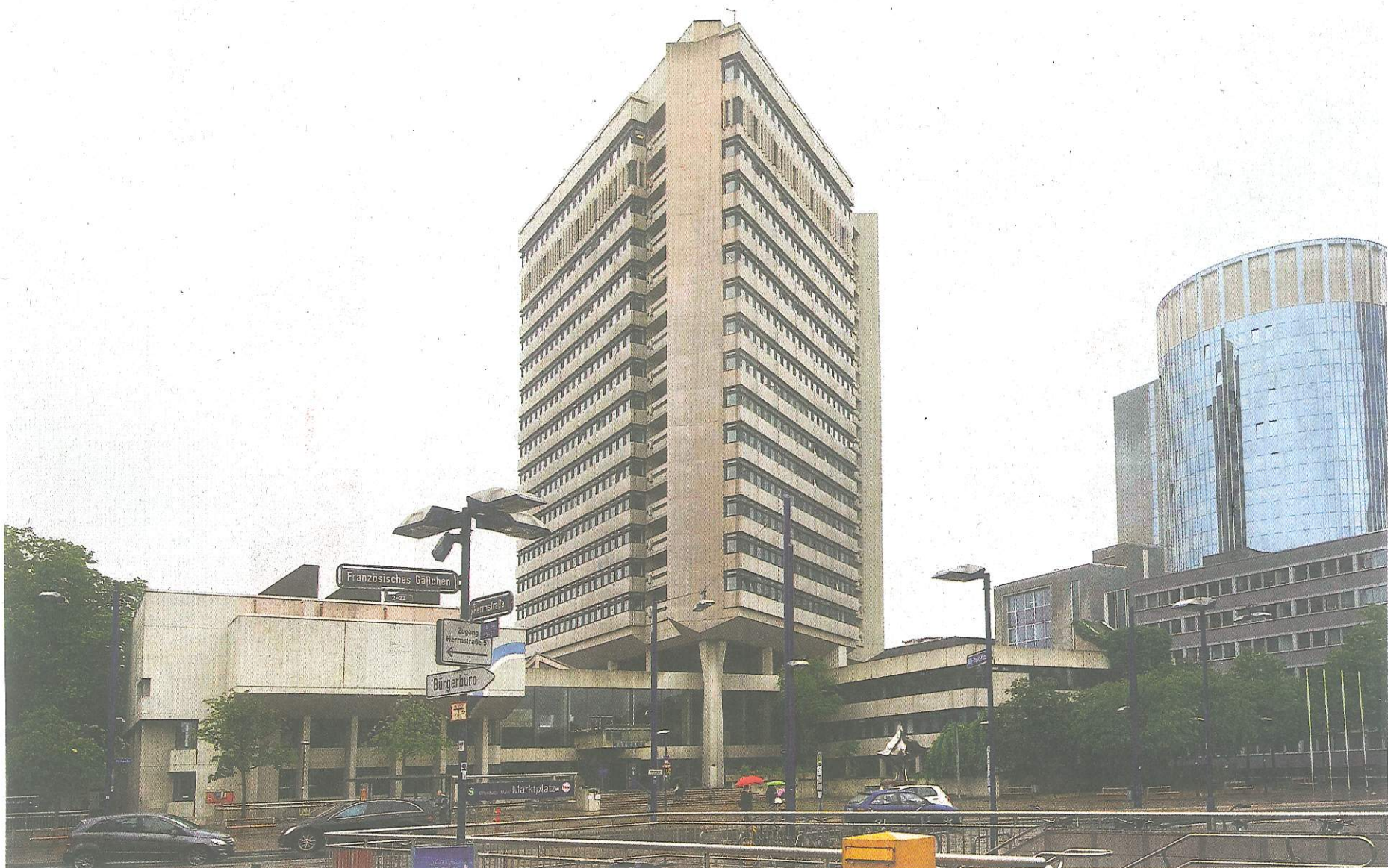
Überragend: Das Rathaus prägt das Bild der Offenbacher Innenstadt. Nun wird der Breitfuß genannte Unterbau des denkmalgeschützten Gebäudes saniert.
