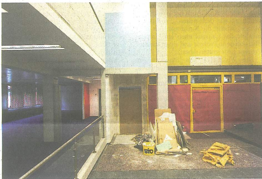
Vorbereitungen: Für zwei Jahre wird der dreigeschossige Trakt zur Baustelle.
