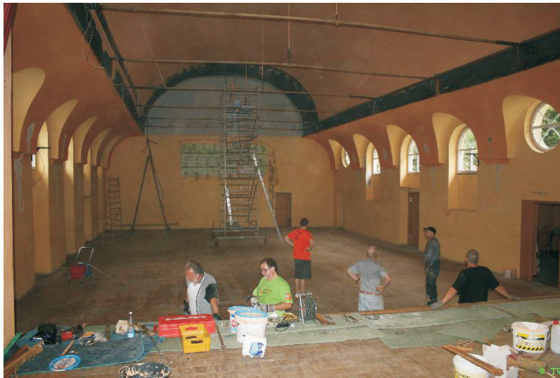
Das Gewölbe ist nun in terracottafarben gestrichen.
