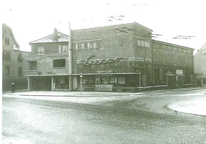
... und nach dem Umbau.
