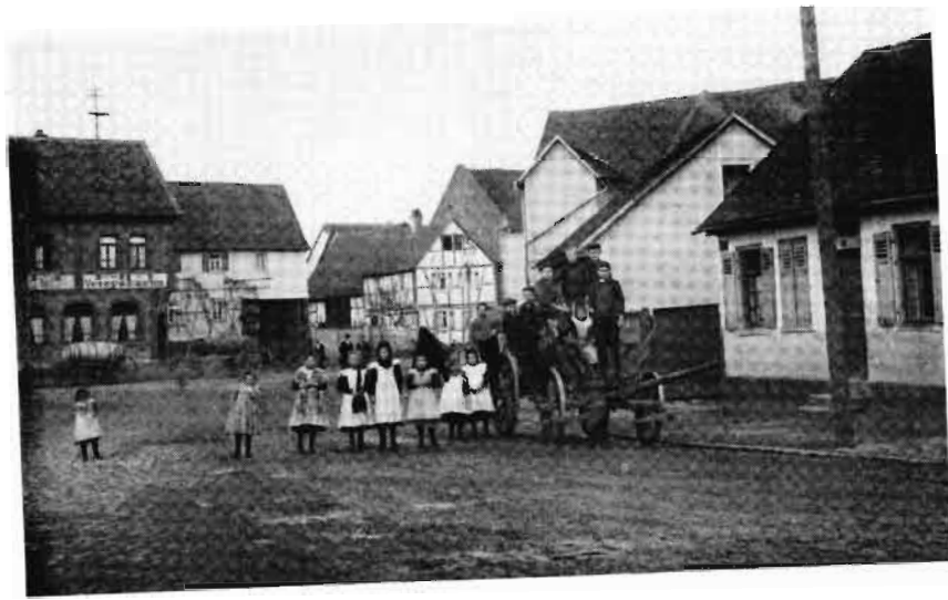
SELIGENSTÄDTER STRASSE UM 1905 Blick von der Bachbrücke zur S-Kurve (Archiv-Photo: Franz Kurt)
